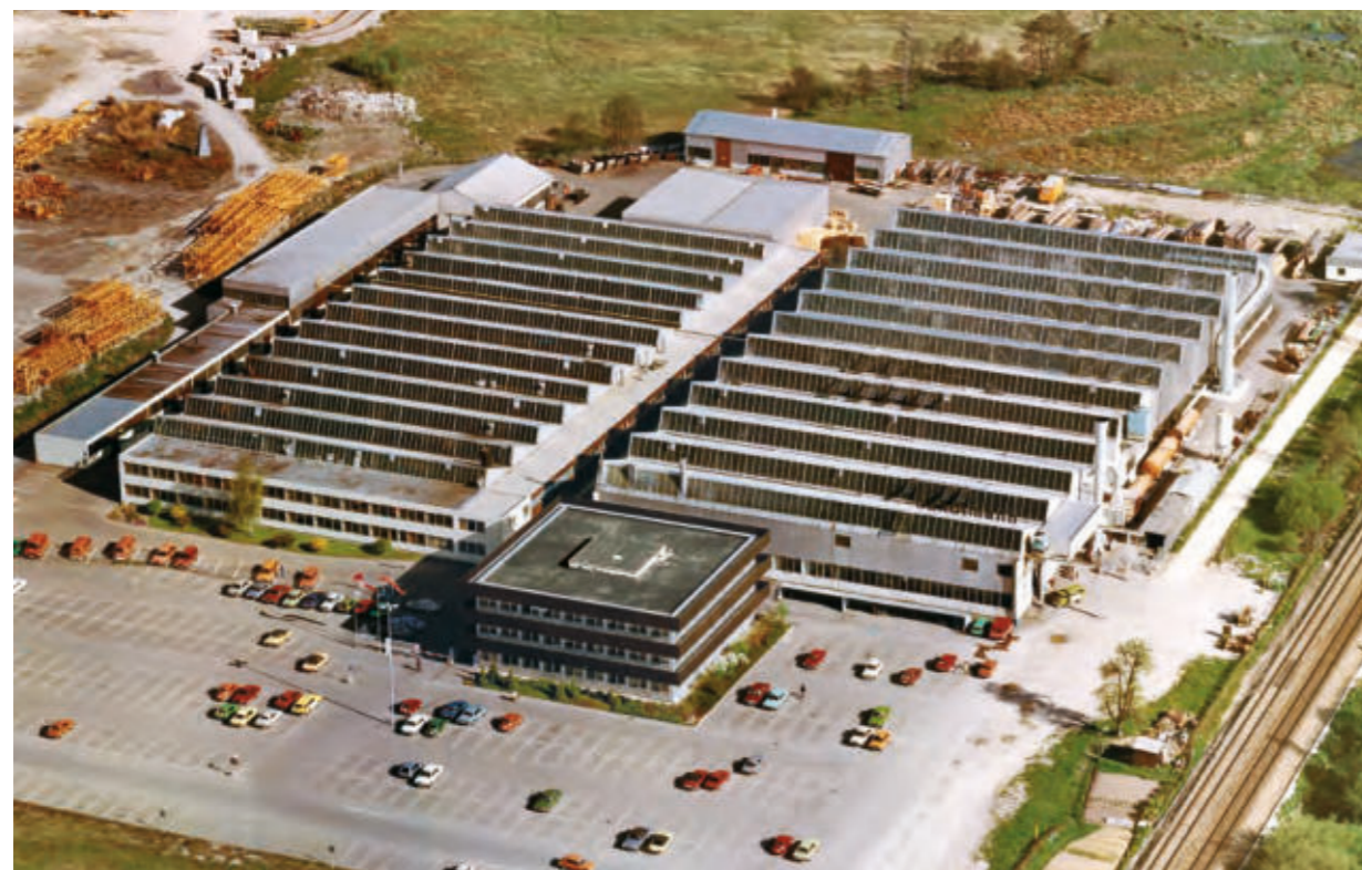
Handtmann 1980 mit erweiterten Hallenbauten
