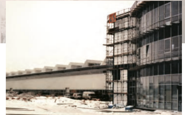
Rohbau der Handtmann Maschinenfabrik, Biberach-Aspach im Winter 1999
