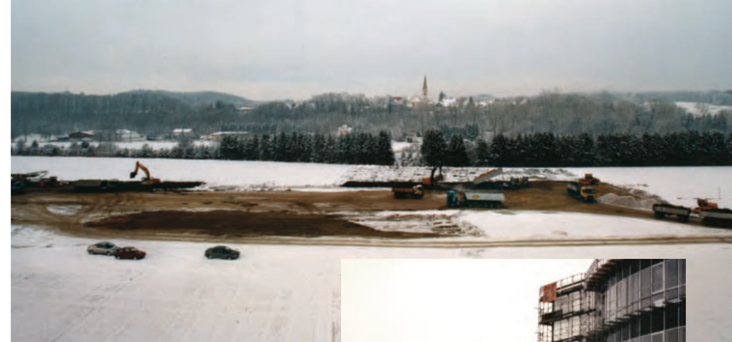
Beginn der Planierungsarbeiten im Baugebiet Biberach-Aspach im März 1999
