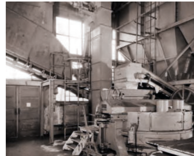
Die automatische Sandaufbereitung für den Sandguss, Handtmann Metallgusswerk, Biberach, Fabrikstraße, 1960er Jahre
