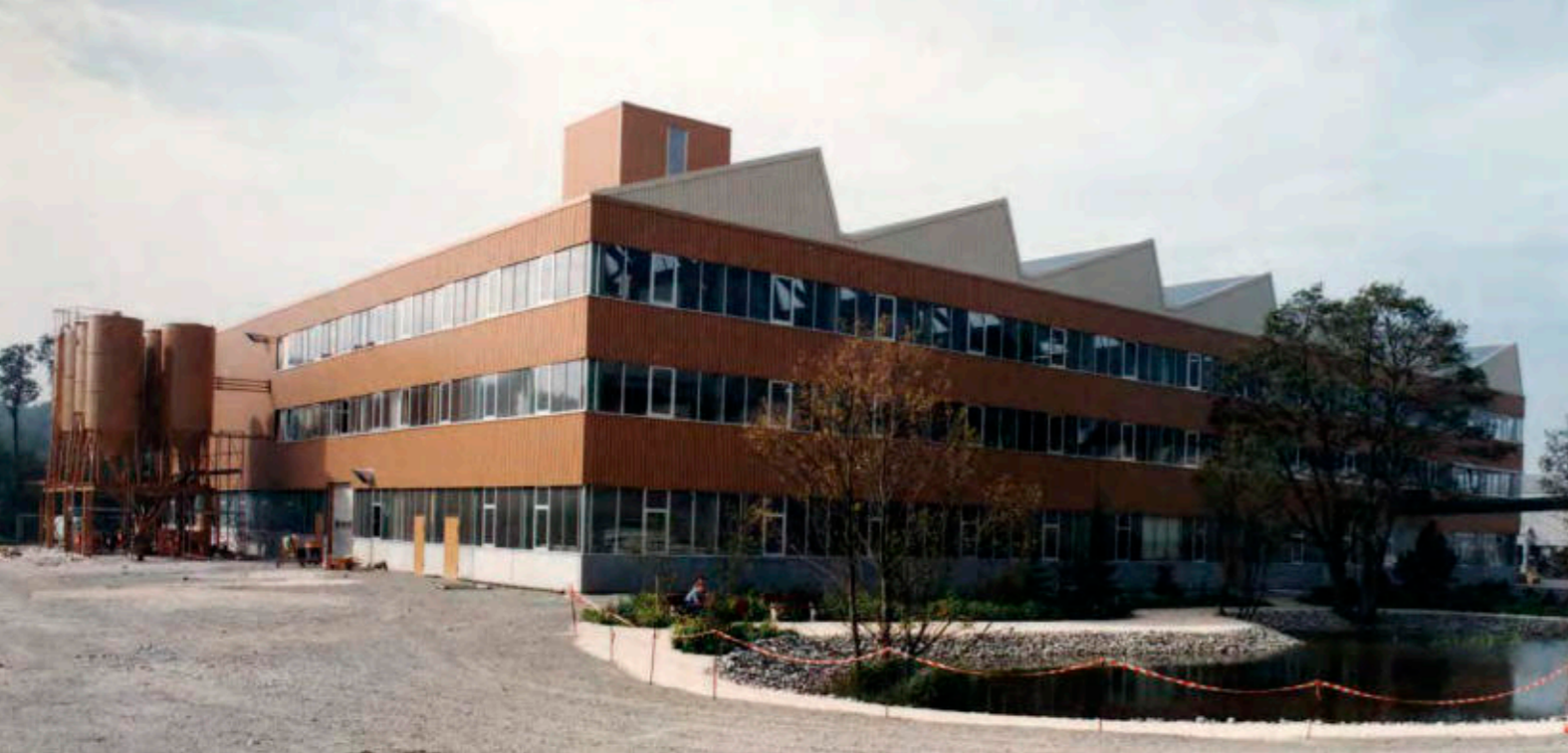
Der Erweiterungsbau für die Gießerei an der Birkenallee, 1982
