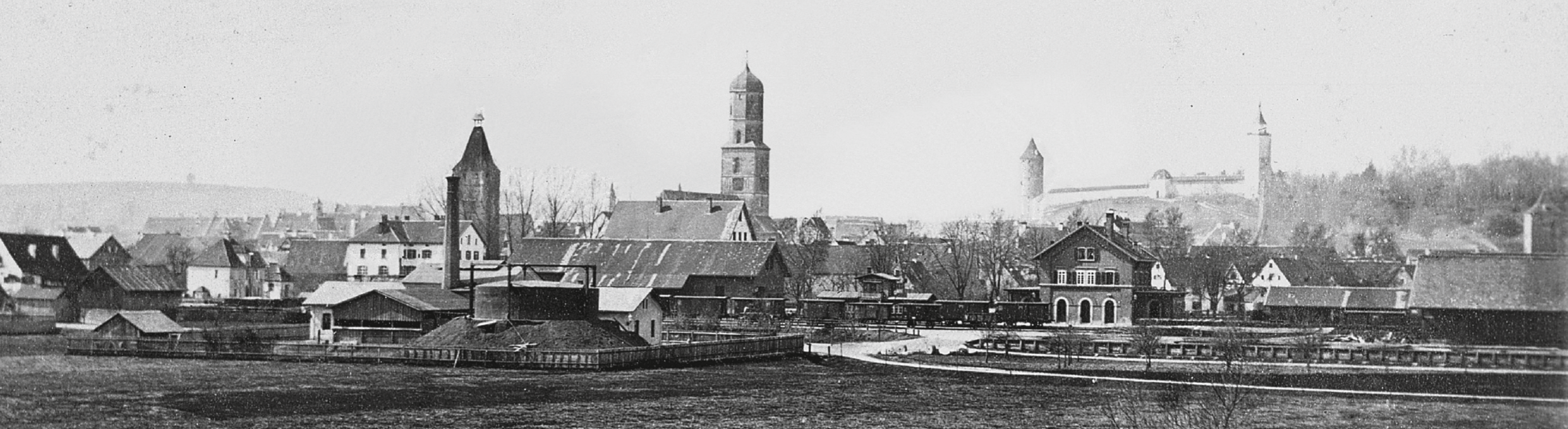
Stadtansicht von Biberach mit Bahnhof, Fotografie um 1867, Städtische Archive Biberach. Im Vordergrund das 1863 erbaute Gaswerk, unmittelbar daneben errichtet die Familie Handtmann 1929 ihren zweiten Firmenstandort.
