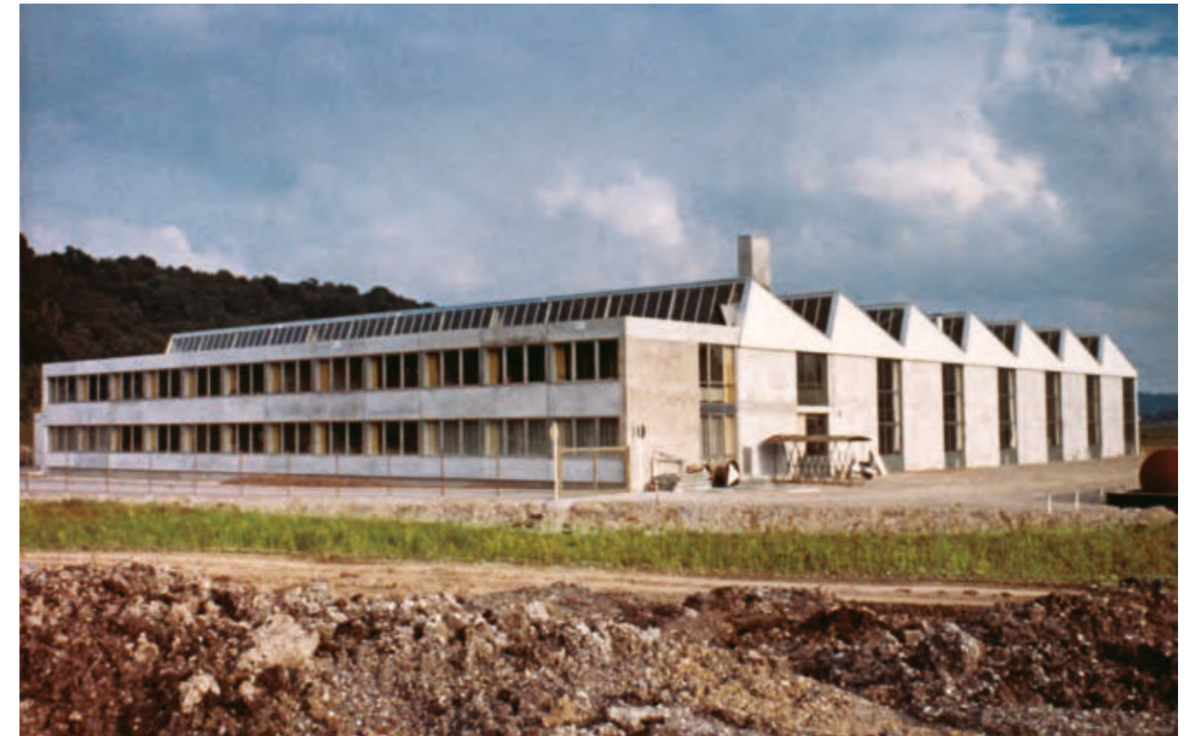
Neubau auf der grünen Wiese, der Rohbau des ersten Handtmann-Betriebsgebäudes an der Birkenallee, Biberach im Frühling 1968
